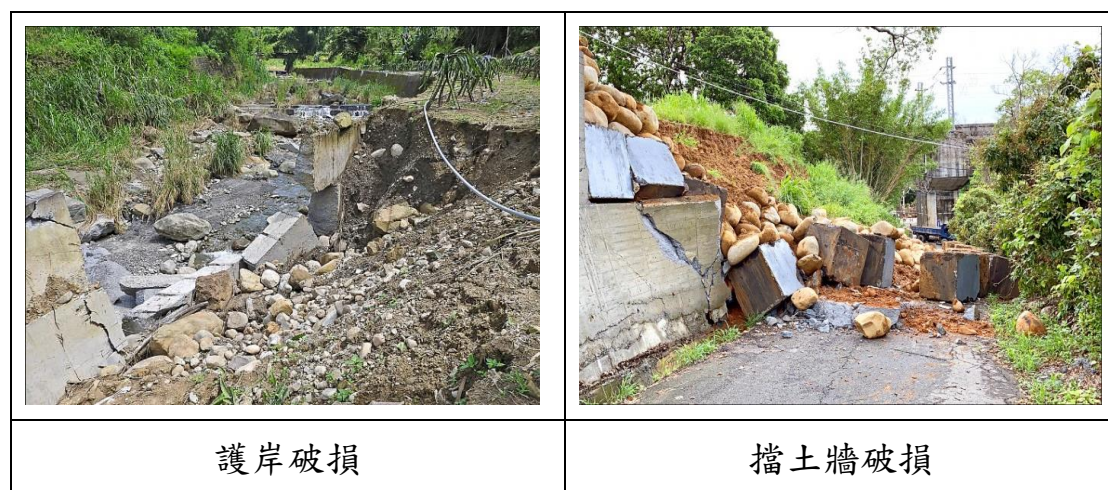
圖4-10 災後常見損毀構造物
