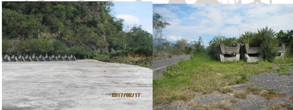
圖4-12 防汛塊體堆置場地
