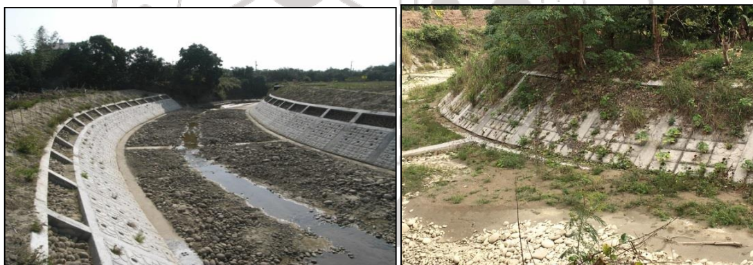
圖2-7 預鑄塊施工情形
