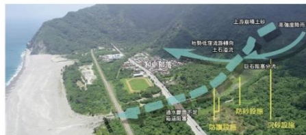
蘇拉颱風後和中部落野溪上游土石防治工程
