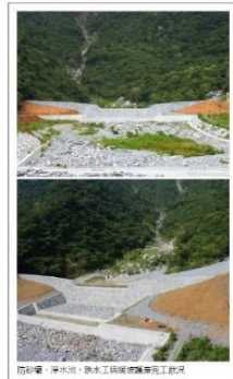
防砂壩、沉砂池、跌水工與緩坡護岸工程
