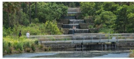
二號濕地與四號濕地所匯集之水經由排水管道匯入一號濕地
