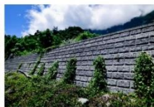
108年防砂壩壩面堆石壩面
