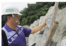
壩面堆石石線型平整，壩面層層石貼近自然
