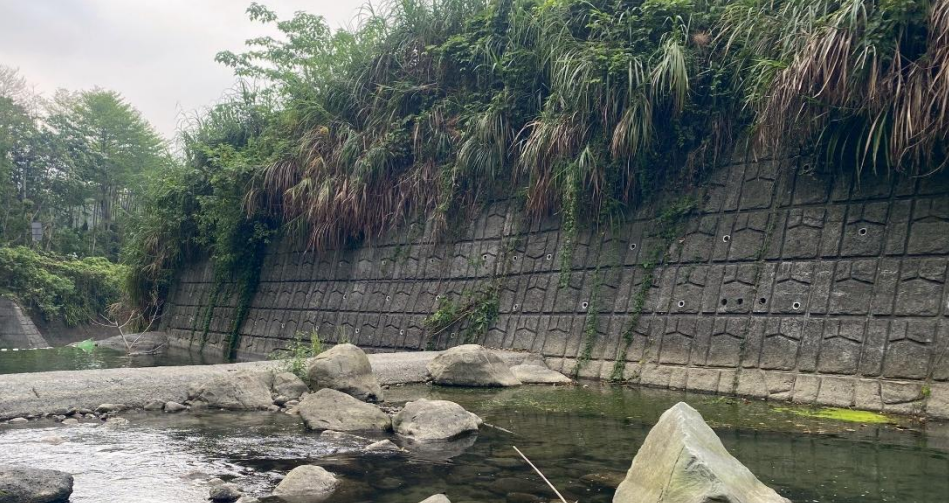
南投縣鹿谷鄉-和雅橋
