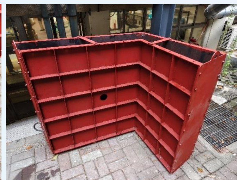
完成鐵模組立
