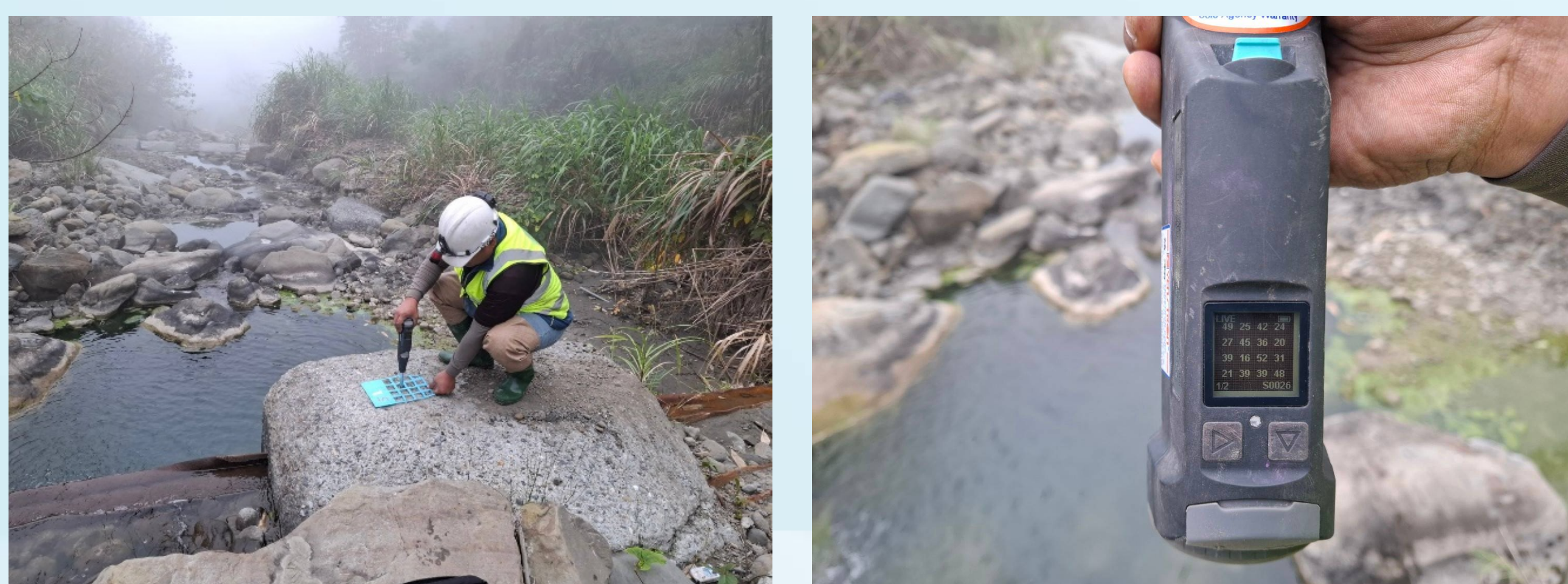
圖3 定量檢測-混凝土強度檢測紀錄
