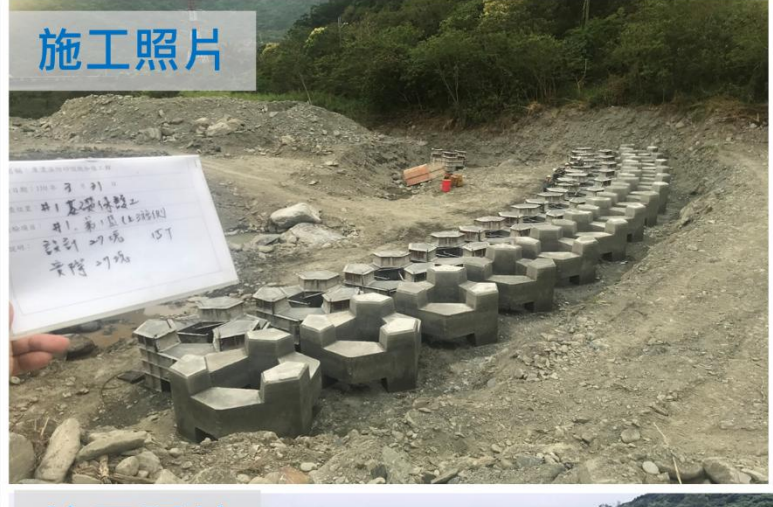
110年庫濃溪防砂設施加強工程
