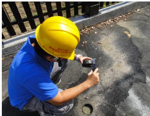
圖 2-16 瀝青混凝土厚度量測
