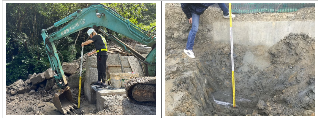
圖 2-29 隱蔽部分開挖檢驗
