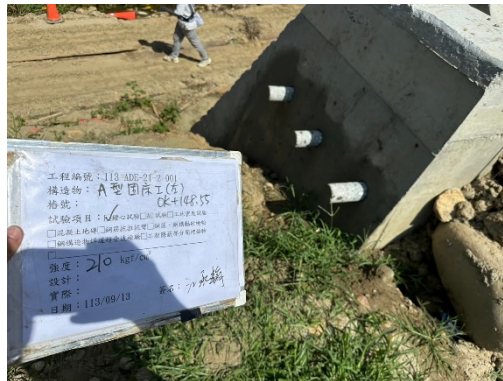
圖 2-12 各鑽心試體間距分布
