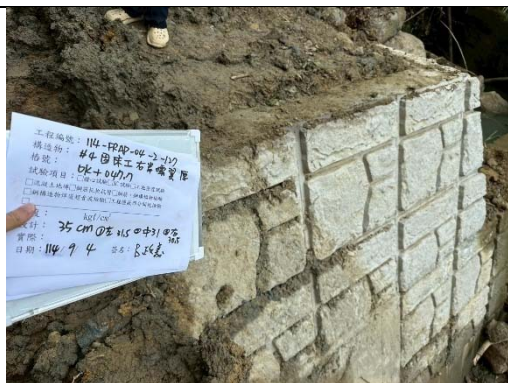
0K+047.7 #4 固床工(右翼) 頂厚設計 35cm；實際 30.5 cm、31 cm、31.5cm
