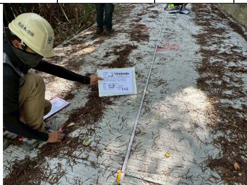
PC 路面鋪設伸縮縫間距設計小於 8m；實際值 15.15 m、10.12 m、10.5 m
