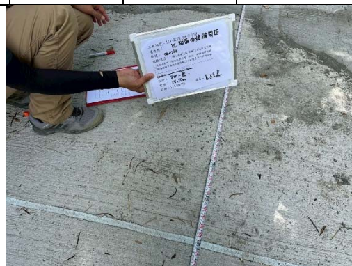
PC 路面鋪設伸縮縫間距設計小於 8m；實際值 15.15 m、10.12 m、10.5 m
