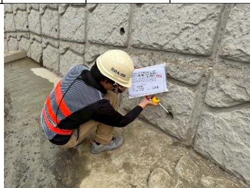
PVC 管壁厚度未符合設計尺寸設計尺寸 \geq 5\text{mm} ；實際值 3.5mm、3.5mm、3.5mm
