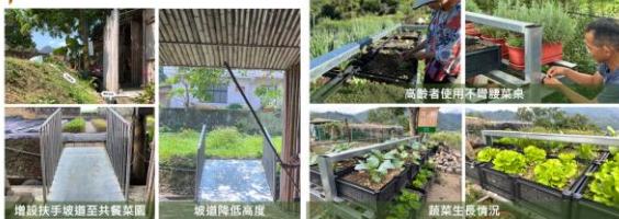
增設扶手坡道至共餐菜園 坡道降低高度 高齡者使用不鏽鋼菜園 蔬菜生長情況
