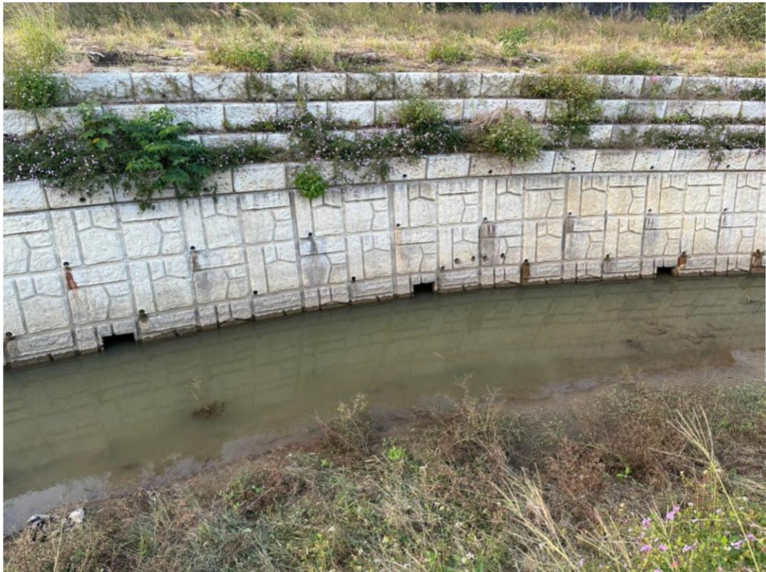
圖 2-5 崎林橋上游生態槽混搭造型模板護岸
