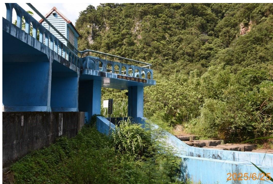
圖 3-14 福德坑圳渠首工
