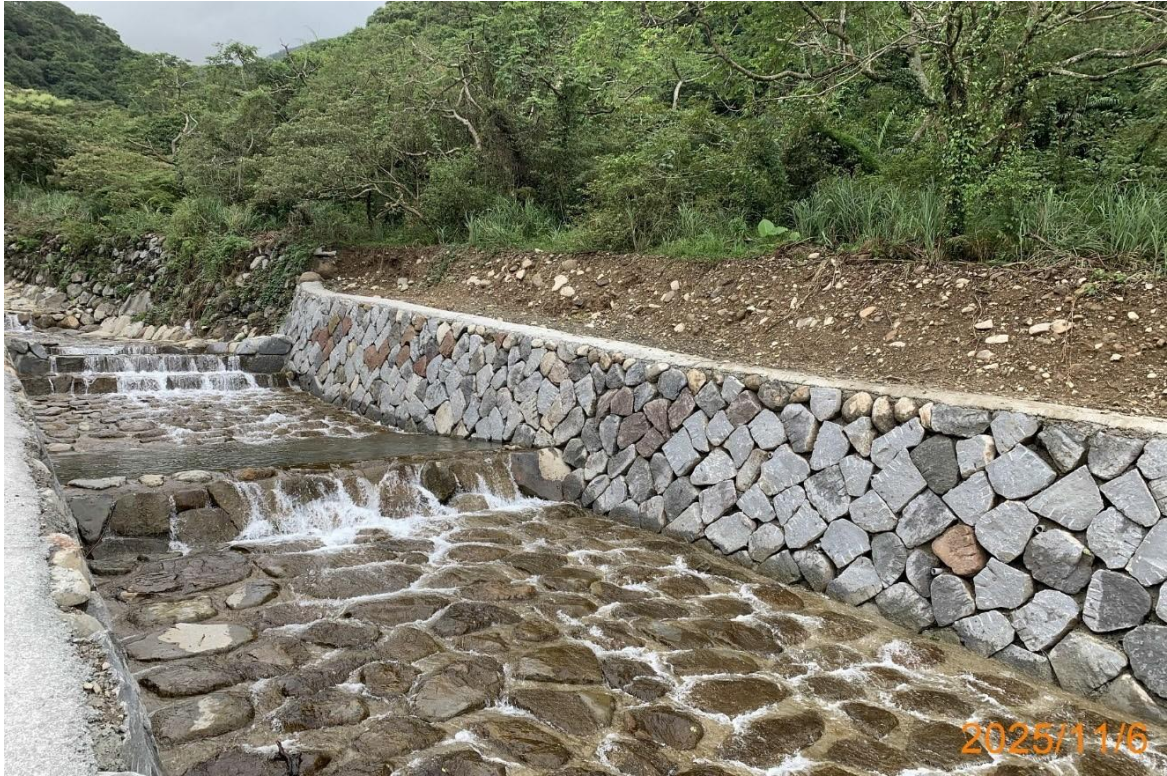
圖 2-3 新北市金山區環湖三橋上游乾砌石護岸 一、布置原
