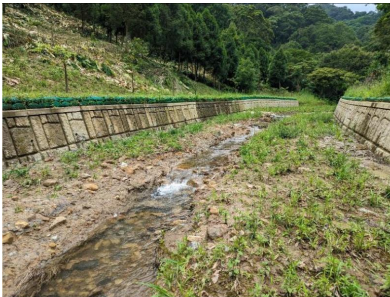
a. 長興里 4 鄰喜龍農路旁野溪整治改善工程
