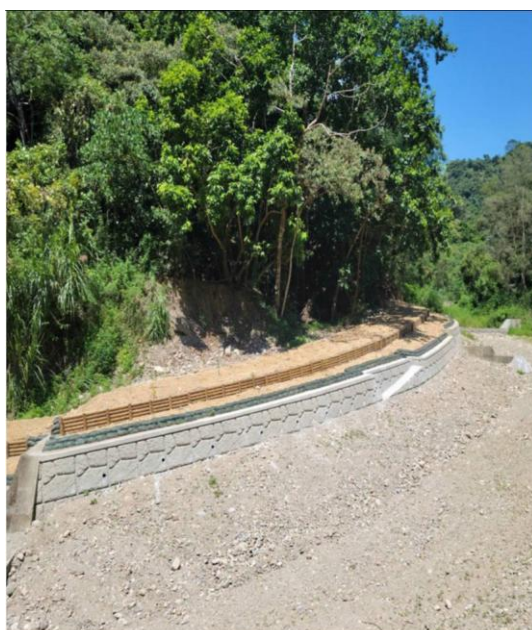
b. 埔里區 11~12 林班坑溝第三期整治工程
