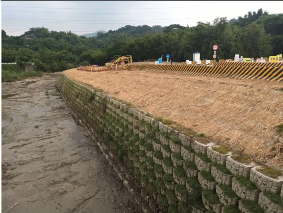
d. 六溪里石廟旁野溪整治工程
