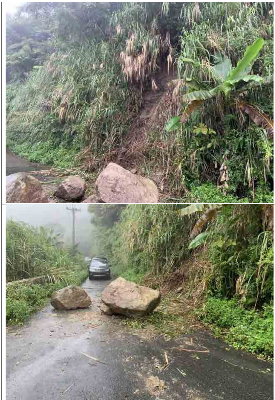
圖 5-12、民國 111 年 3 月 23 日第 019 號地震造成落石災害 (照片來源：自由時報 https://news.ltn.com.tw/news/life/breakingnews/3868995 )
