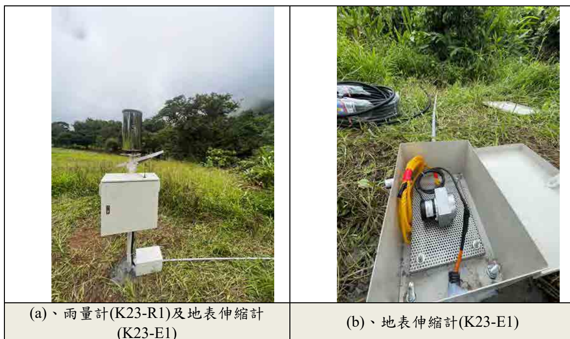
圖 5-43、K23-E1 地表伸縮計現場環境
