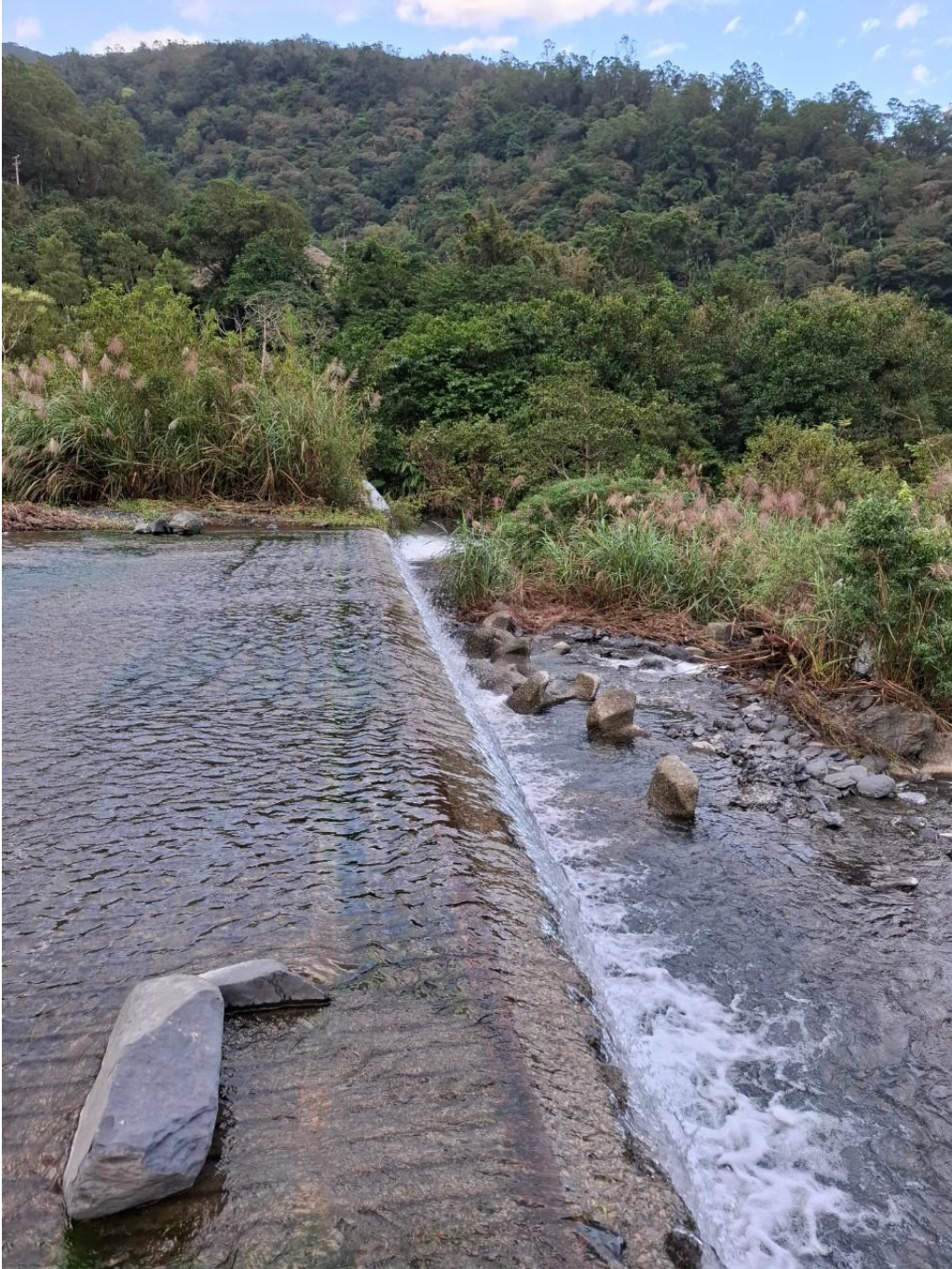
圖 2- 22 大礁溪-01-A11-92 混凝土防砂壩(資料來源：本計畫製作)
