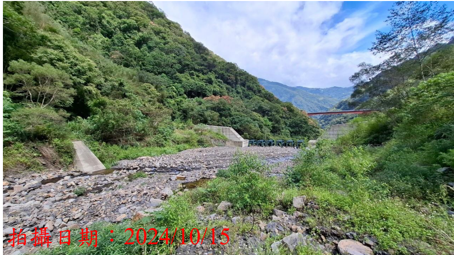
圖 2-17 蘇樂樣區壩體(資料來源：本計畫製作)
