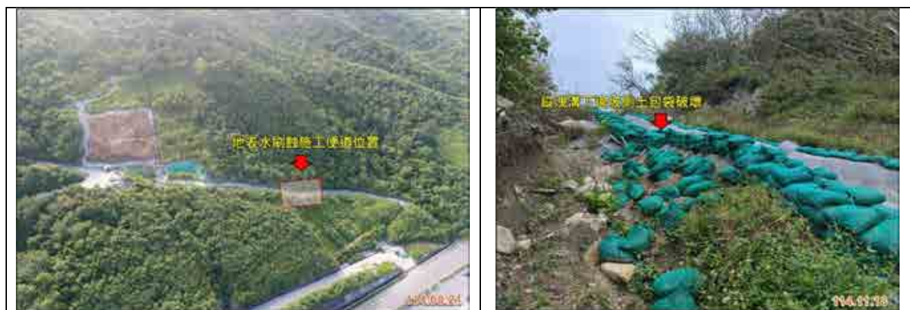
圖 3-107、第三期工程完成後局部區域建議改善缺失(施工便道未復舊)
