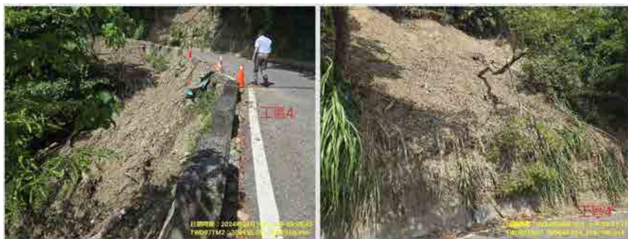
圖 3-124、花蓮縣壽豐鄉山嶺農路沿線凱米風災復建工程工區現勘照片
