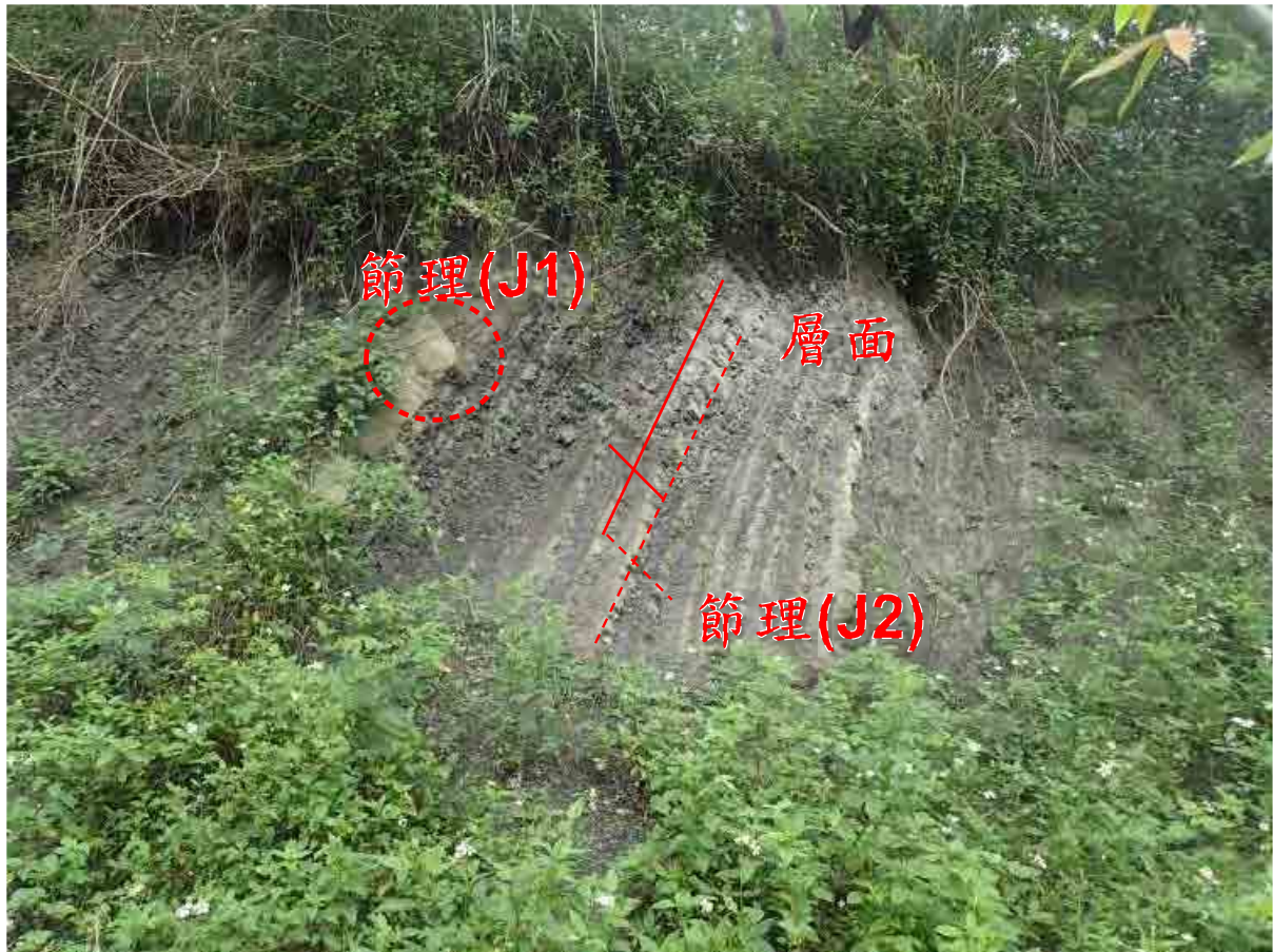
照片 3-4、蕃薯寮層露頭及位態
