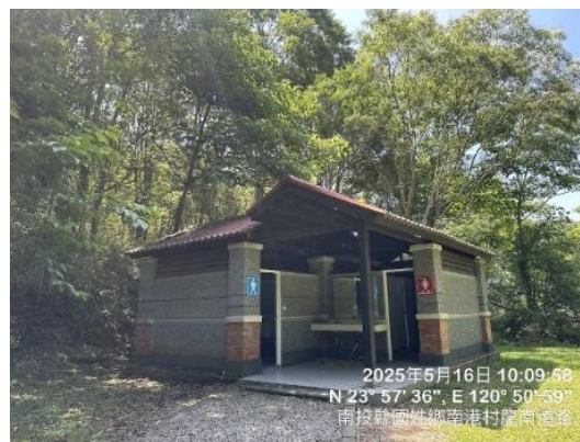
圖 2-5、九份二山傾斜屋旁公廁現況
