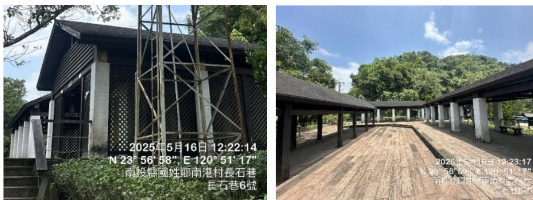
圖 2-1、九份二山石門觀景台公廁、休憩涼亭現況
