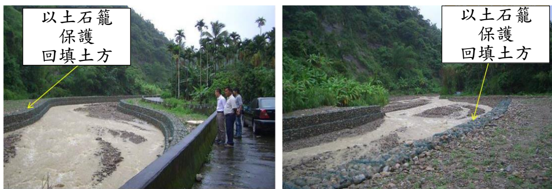
圖 3-12 土石籠土方堆置保護措施案例
