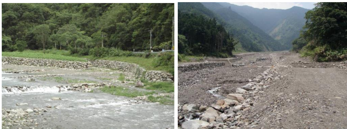
圖 3-7 集水區內河岸型土砂堆置區示意照片
