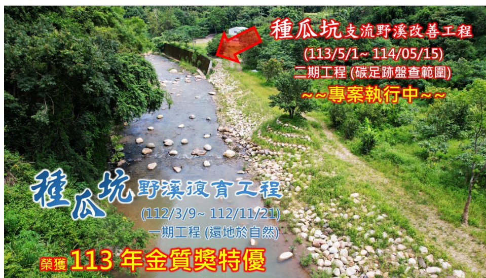
圖 5-1 種瓜坑支流野溪改善工程
