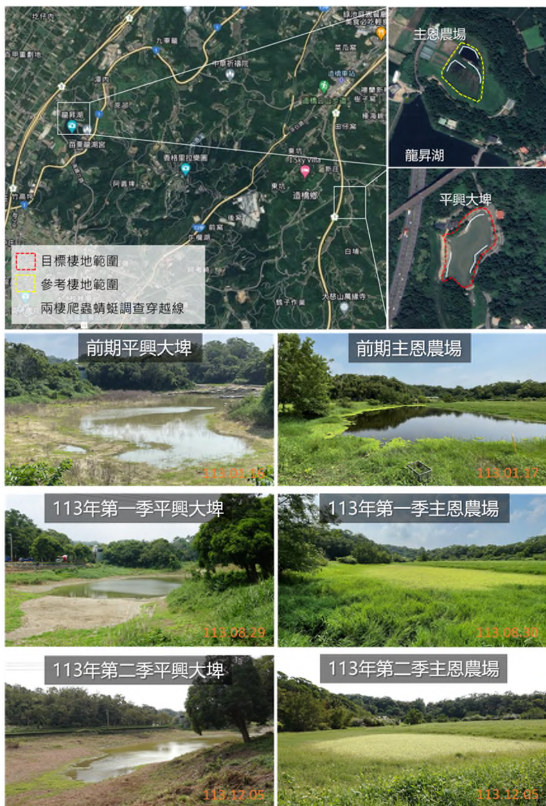
圖 4.3.1-1 平興村大埤滯洪農塘改善工程-樣區環境概況
