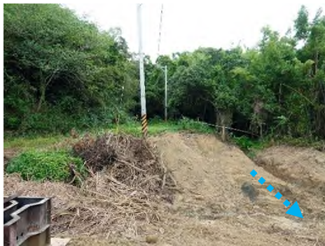
工區內上游段鄰近次生林 (拍攝於2024.07.10)
