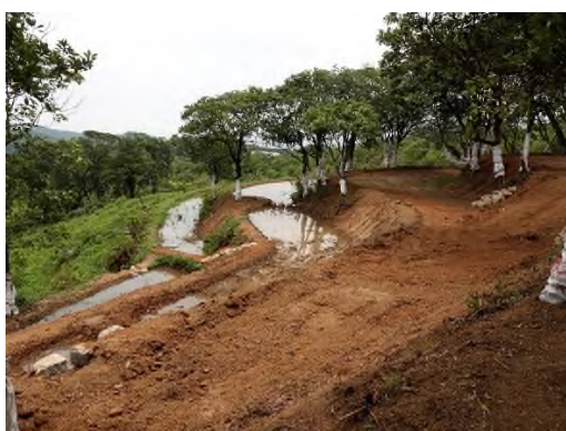
梯田區既有樹木已包覆保護 (拍攝於2024.08.07)
