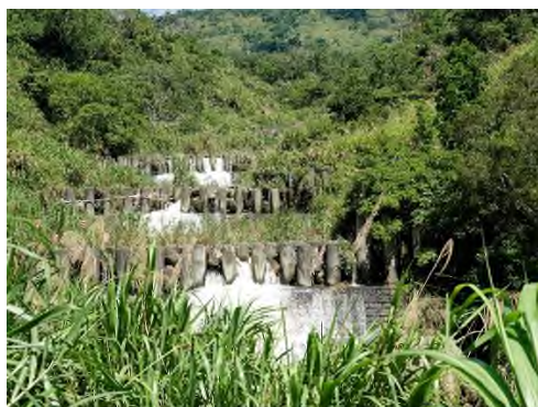
工區內既有溢洪道 (拍攝於2024.07.11)
