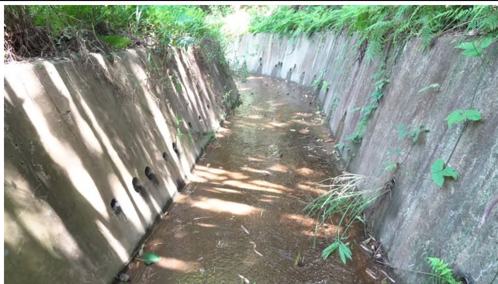
南河村 3 鄰新庄腳坑溝整治工程，因為飯島氏銀鮎潛在棲地，執行一級生態檢核作業，然工程採型矩形排水溝設置，無法提供飯島氏銀鮎棲息利用。(2024.08.22 拍攝)
