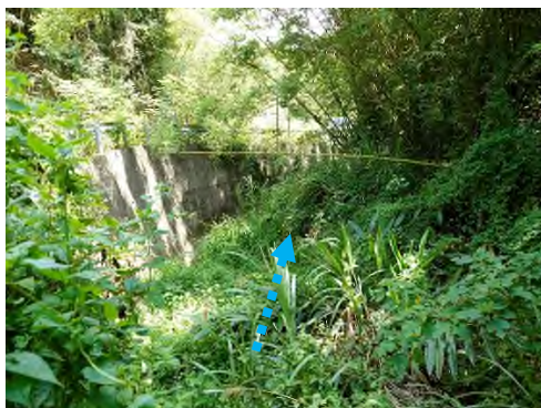
工區中右岸竹林及次生林 (拍攝於2024.07.10)
