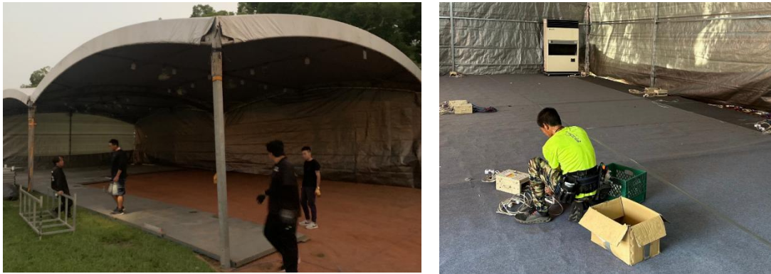
圖 二-6 場館相關設備施作情形
