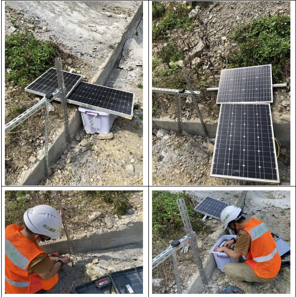
圖 2-6 GNSS 監測點現場架設範例
