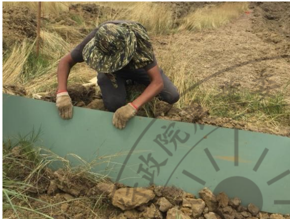
圖 3-3(c) 將鋼板插入土中
