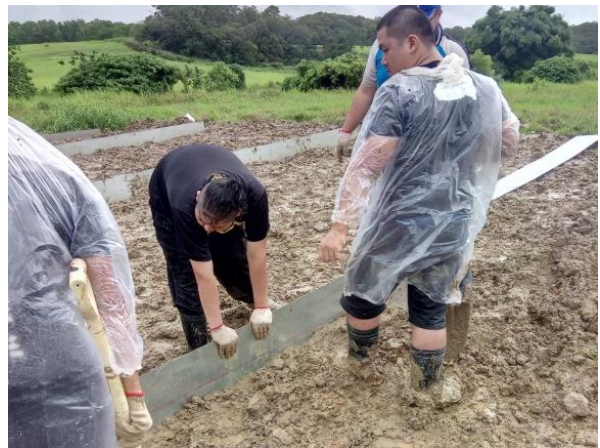
圖 3-6(b)重新設置較厚的鋼板
