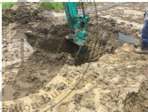
圖 3-10(b) 清理土壤收集槽
