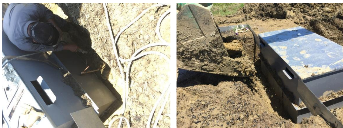
圖 3-10(f) 鐵棒與鋼桶焊接固定並將土回填
