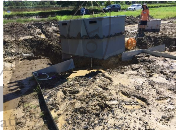
圖 3-10(c) 利用水準儀定位，使土壤收集槽高度平均
