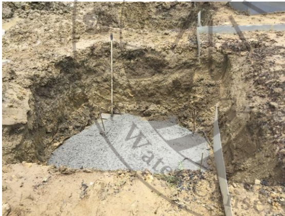
圖 3-10(c) 利用水準儀定位，使土壤收集槽高度平均
