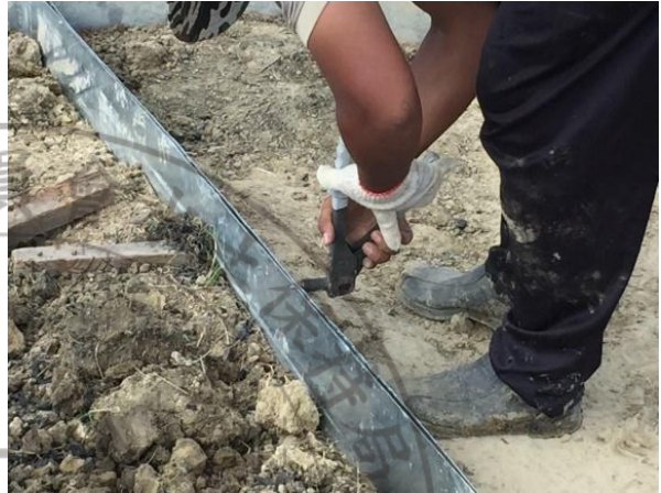
圖 3-6(d)鋼板交接處以鋼釘固定
