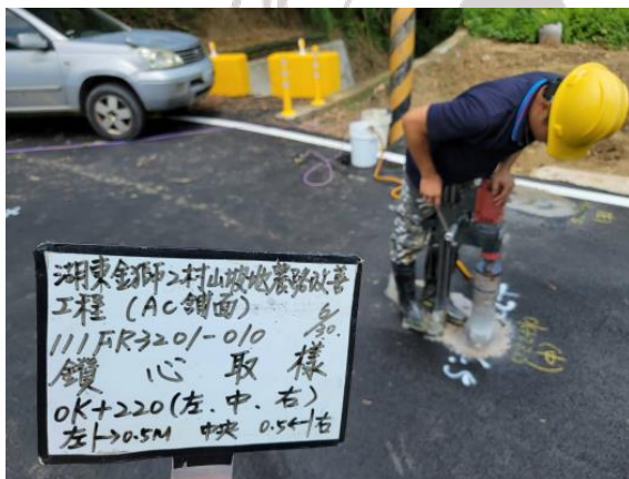
圖 2-10 瀝青厚度鑽心檢測照片
