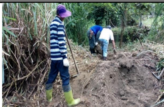
圖 3-14 整理溪岸連接至社區的路跡，將挖掘出的石塊利用於溪岸護坡
