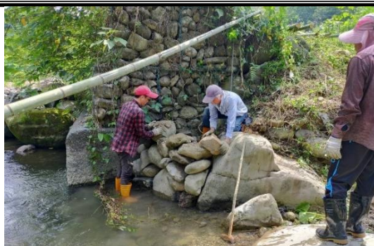
圖 3-15 以砌石工法鞏固溪岸邊坡，以利橋面搭設
