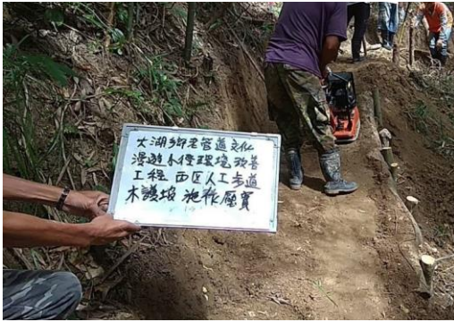
圖 4-6 小型機具輔助路面小徑 夯實
