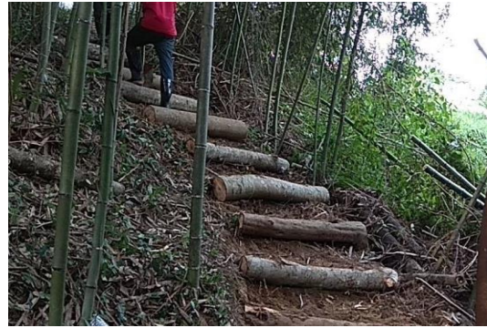
圖 4-7 依機關及監造指示設置 構造物
