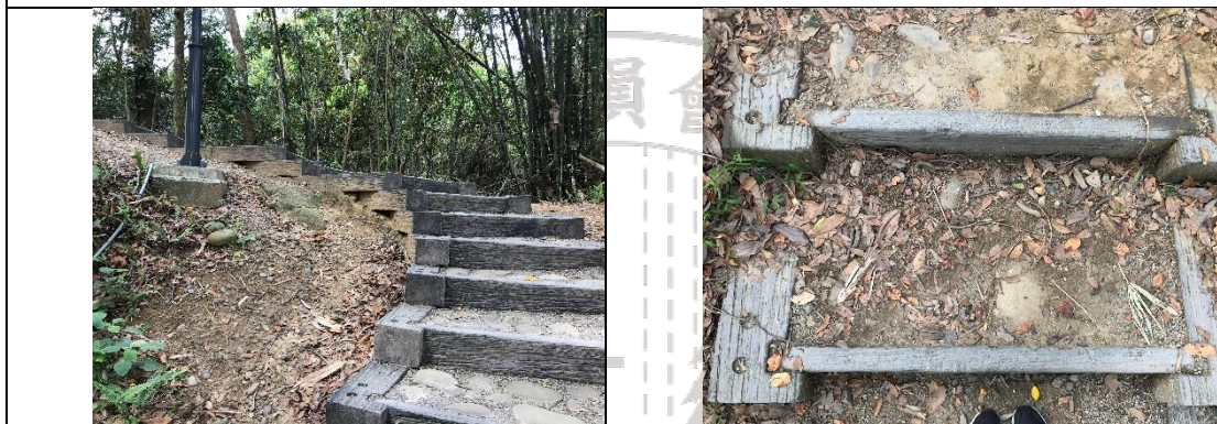
圖 4-20 龍騰斷橋步道-木格框階梯(盡量不使用仿木材料)
