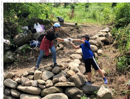
圖 3-11 就地取材石塊，透過人力傳遞修護步道
