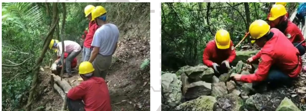
圖 3-3 仙山古道修護(橫木路緣、砌石護坡)
