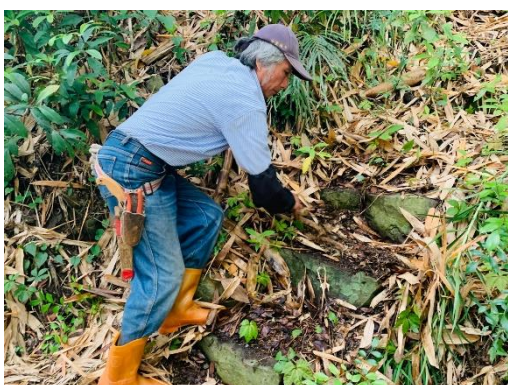
圖 3-8 以石塊形成階梯改善過陡問題，同時形成自然度極高步道
