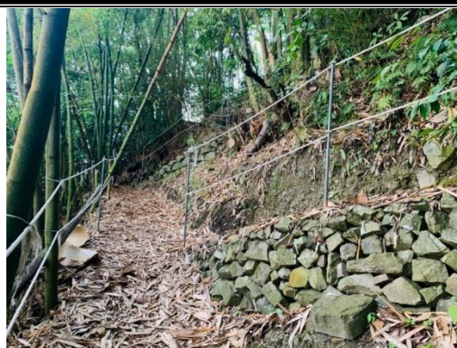
圖 3-7 以石塊鞏固邊坡
