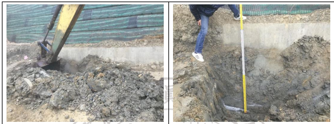
圖 2-28 隱蔽部分開挖檢驗
