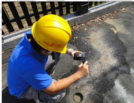
圖 2-16 瀝青混凝土厚度量測
