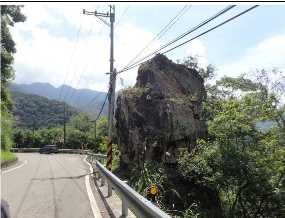
(B) 硬頁岩偶夾砂出露情形 (台 7 線約 40.7K)
