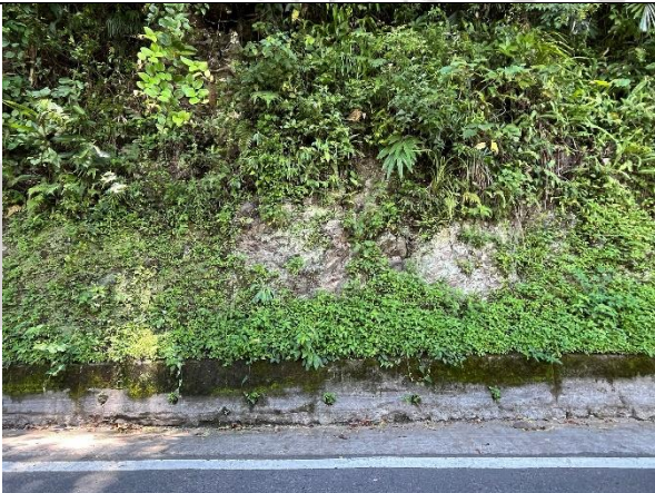
(D) 硬頁岩偶夾砂出露情形 (台 7 線約 40.9K)
