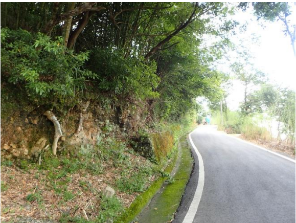
(F) 調查區硬頁岩出露情形，有明顯 風化情形(調查區外，台 7 線約 41.2K)
