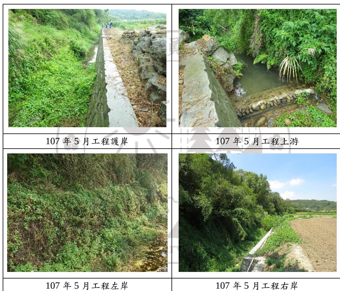
圖 2.1-12 通霄鎮城南里北窩野溪治理工程環境現況
