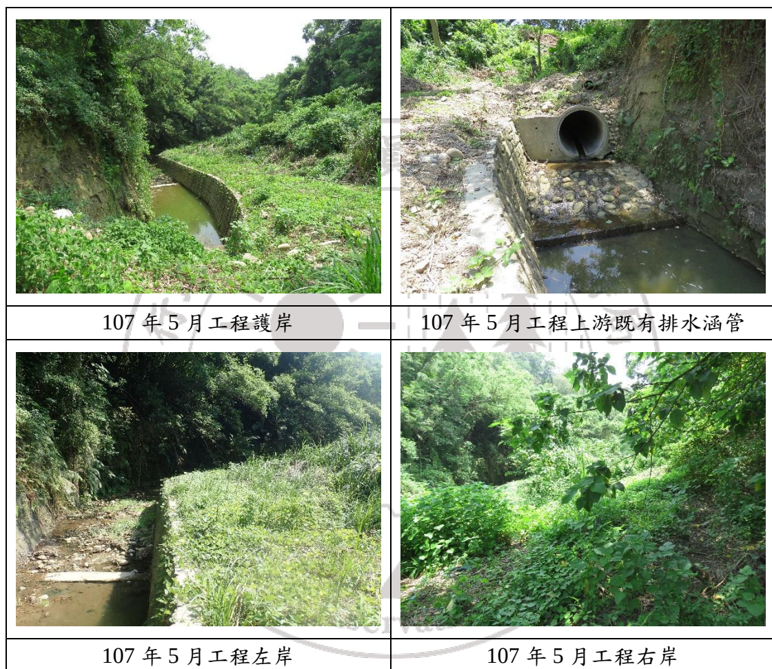
圖 2.1-8 五湖村及二湖村 8 鄰李賜賓宅側坑野溪治理工程環境現況
