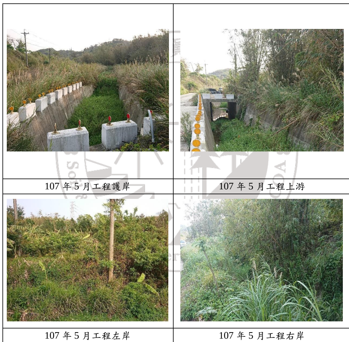
圖 2.1-19 福源里平福幹 45 支 21 電桿旁野溪治理工程環境現況
