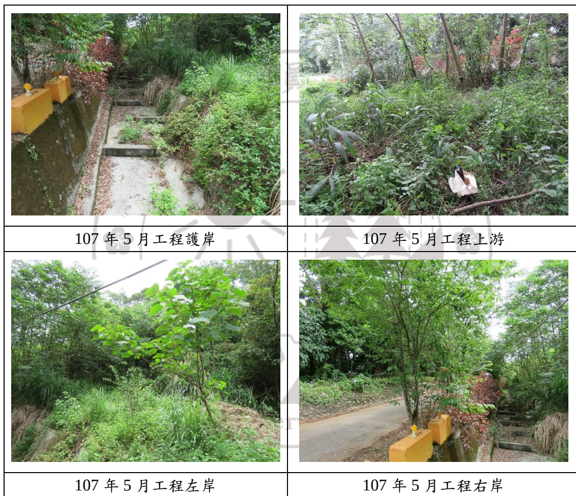
圖 2.1-14 三義鄉雙湖村三角山野溪治理工程環境現況
