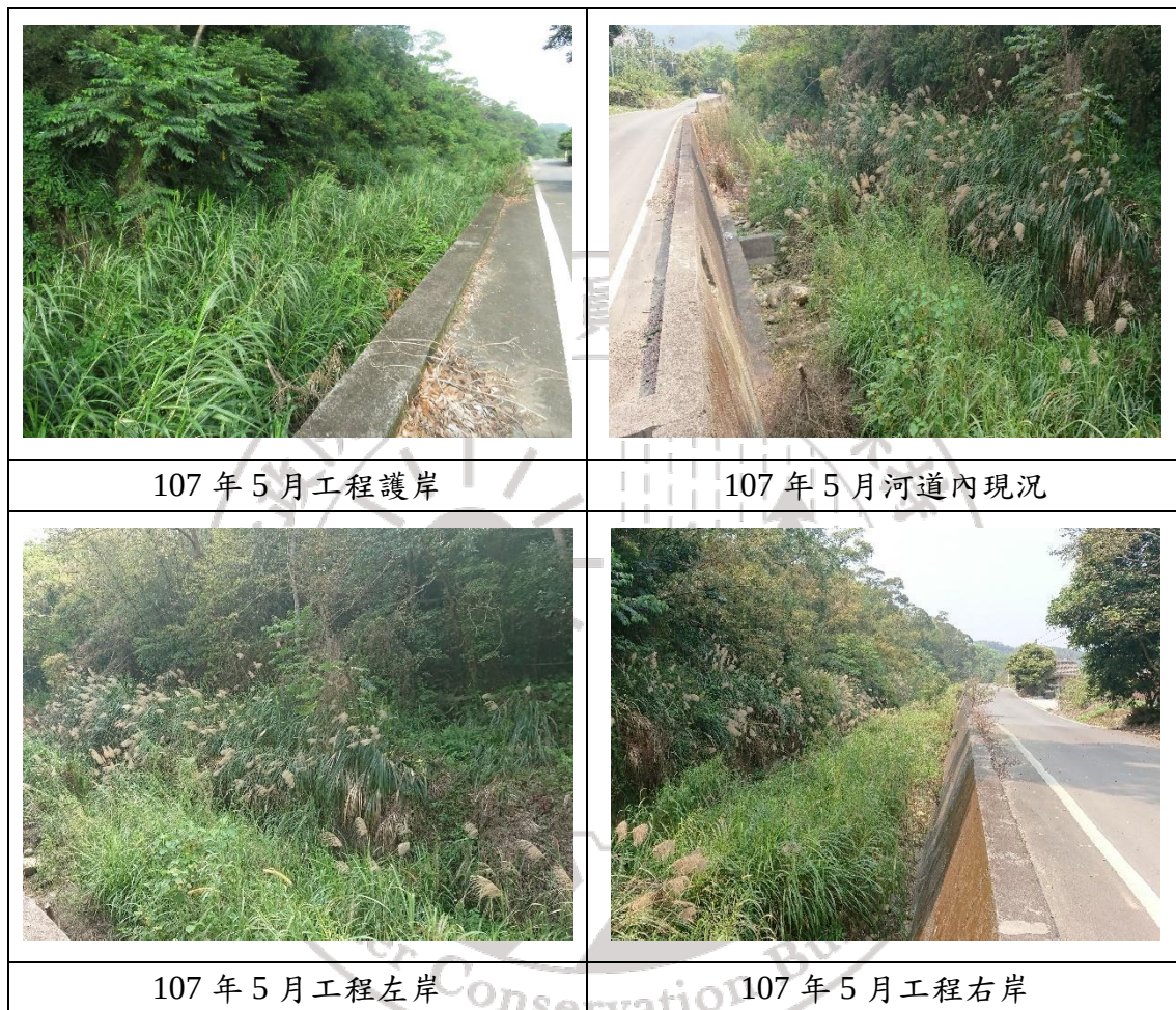
圖 2.1-15 蕉埔里 4 鄰乾坑野溪整治工程環境現況
